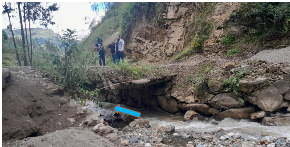
FIGURA N°01: TRAMO CRÍTICO EN LA QUEBRADA CHORRO BLANCO SECTOR RUPAYBAMBA SE APRECIA LA ACTIVACION DE LA QUEBRADA Y QUE EL PUENTE NECESITA PROTECCION EN EL TALUD DE LA MARGEN IZQUIERDA
